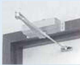
El cuerpo va instalado en la jamba del contramarco de la puerta y el brazo va sujetado a la puerta.
